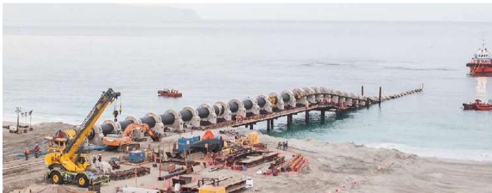
Figura 6.1. Descarga de salmuera: a) Lanzamiento de un emisario en la Bahía de Mejillones 21 . b) Detalle del difusor y las portas de descarga durante el lanzamiento de un emisario en la misma bahía 22 . c) Descarga de salmuera desde una porta 23 . d) Esquema de una pluma salina sometida a una corriente. Fuente: Elaboración propia y Winckler (2021).
