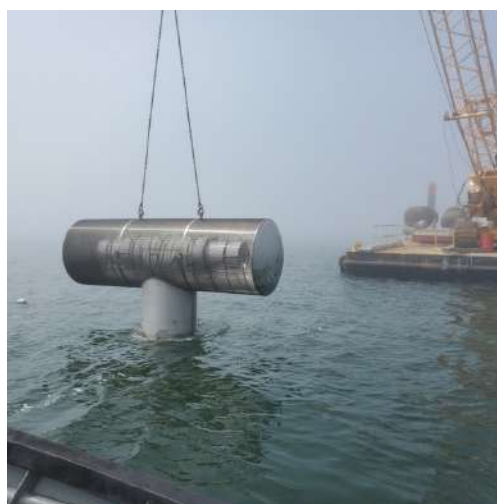
Figura 3.5. Equipos de cribado: tambor rotatorio con malla y sistema mecánico de limpieza (izq.), y malla barril pasiva (der.).
