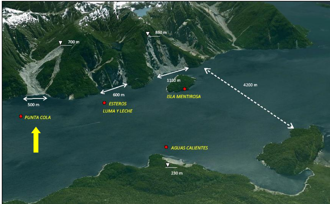
Figure 10: Landslide at Punta Cola.
