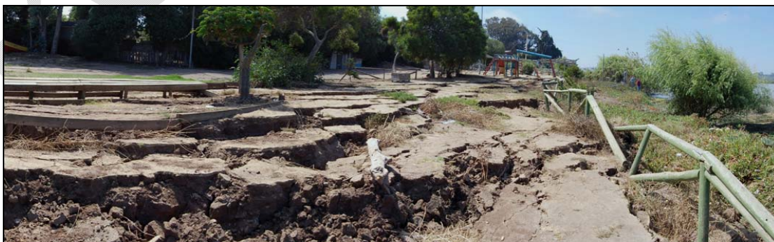
Figura 3-15: Falla de suelo en la ribera del Río Maipo, V Región.
