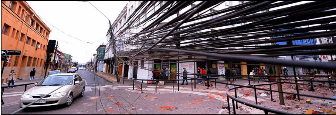
Figura 3-12: Falla de cables telefónicos y eléctricos en Concepción, VIII Región.
