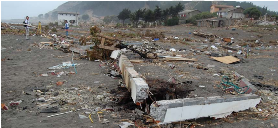
Figura 3-8: Cadenas de vivienda encontradas a decenas de metros de su posición original (al fondo) en Iloca, VII Región.
