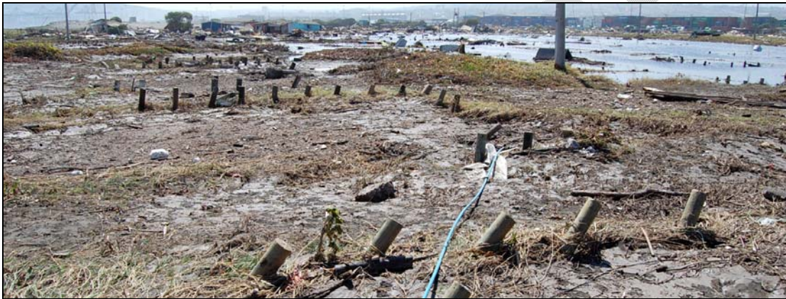
Figura 3-1: Falla de viviendas livianas en Llo-Ileo, V Región.
