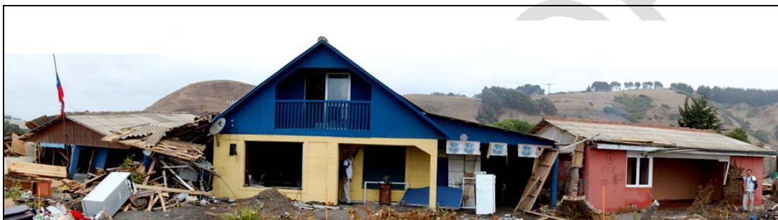
Figura 3-3: Falla de diferentes tipologías estructurales en Iloca, VII Región.
