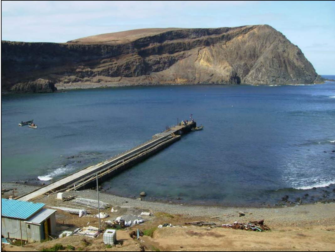
Figura 3-16: Infraestructura portuaria en Bahía el Padre.
