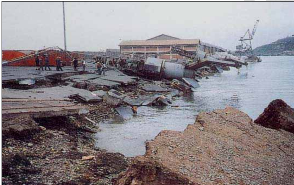
Figura 6-12: Efectos del terremoto de 1985 en el Puerto de San Antonio.
