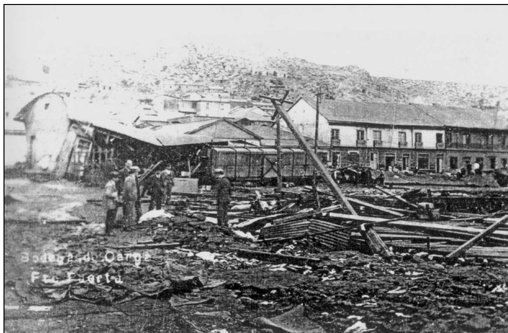
Figura 6-9: Bodegas y oficina del ferrocarril de Coquimbo.
