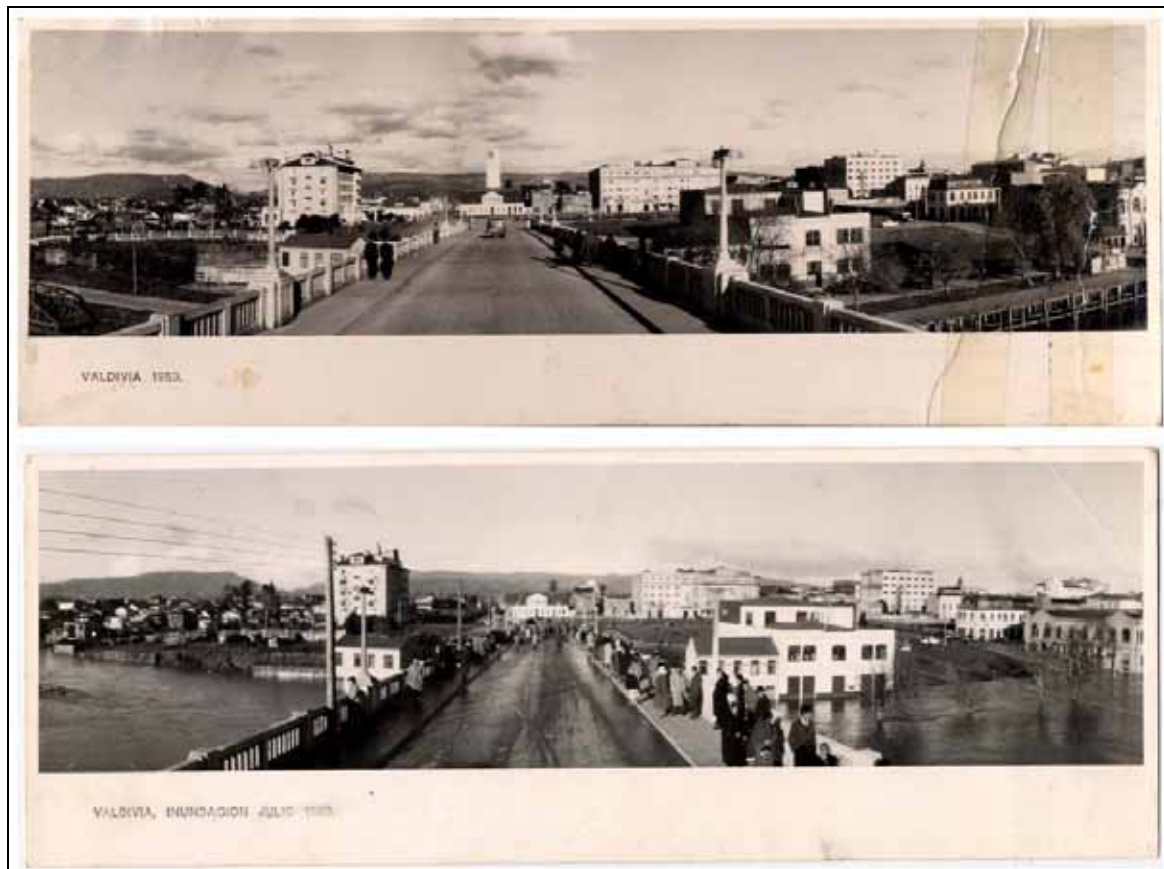
Figura 6-2: Efectos del terremoto de 1960 en Valdivia.
