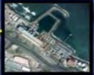
Planta Desaladora Las Palmas III
