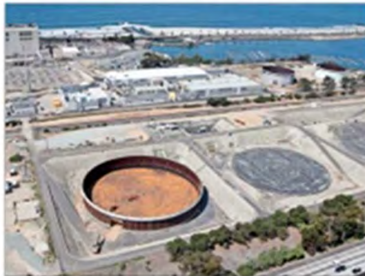
Algunos proyectos piloto que estudian formas de disminuir los desechos tóxicos de la desalinización han demostrado que modificando la salmuera es posible incluso aumentar la producción de algunas especies de peces en acuicultura. En la imagen, la planta desalinizadora de Carlsbad en California, EE.UU., con el Pacífico al fondo.
